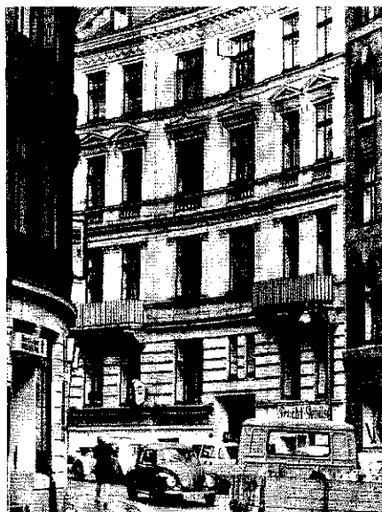
Springer-Mietshaus Brüderstraße 8 Rätsel im Rohr
