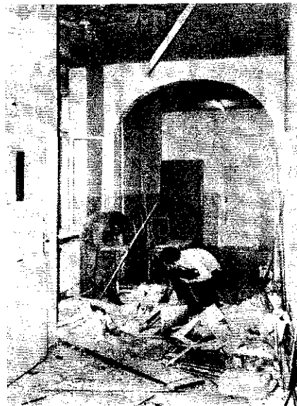
Zerstörtes Polizeibüro* „Das reizt ja dazu“
