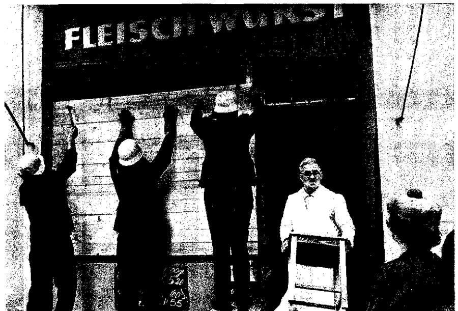
... liegt in der Großstadt offen“: Bombenschaden in München
